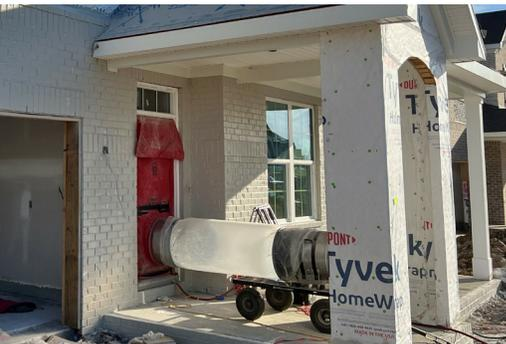
AeroBarrier fue elegido como la solución de sellado de aire de Beazer por su capacidad comprobada para sellar la envolvente del edificio a 1.5 ACH50 cada vez, verificarlo mediante una prueba continua de puerta soplante, y repetir y escalar ese rendimiento en miles de viviendas unifamiliares en diferentes regiones del país.
